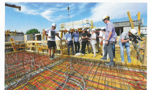
Beim Projekt MGG 22 wird erstmals thermische Bauteilaktivierung im sozialen Wohnbau in Wien eingesetzt. Rohrregister: Hier wird warmes oder kaltes Wasser fließen – zum Heizen oder zum Kühlen
